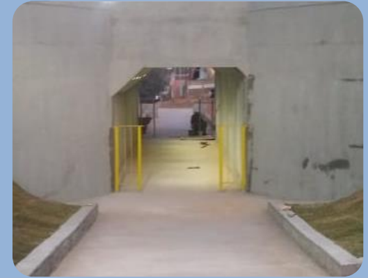
Passagem Inferior Pedestre
