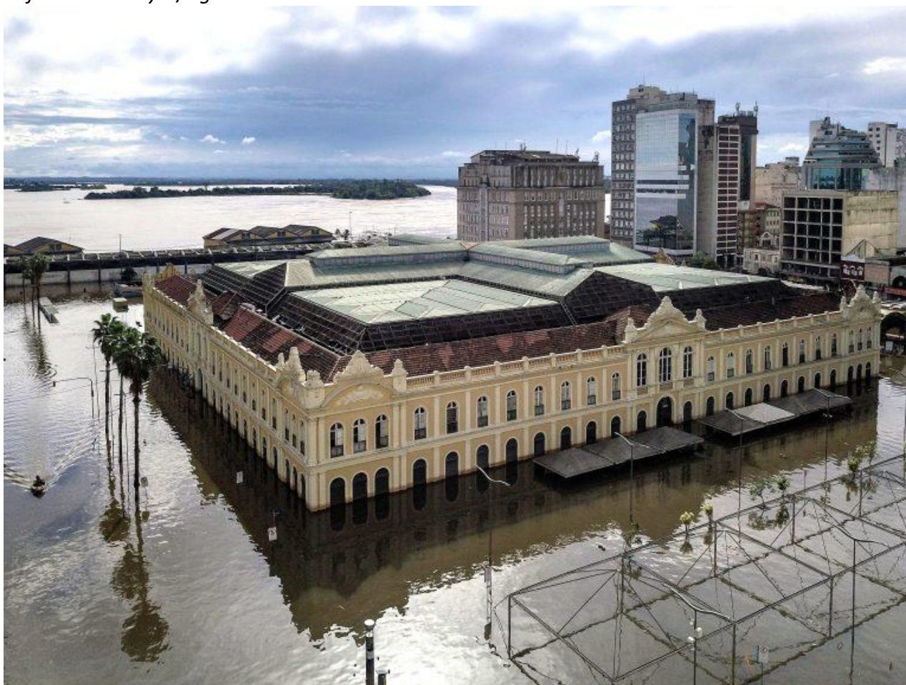
Prédio histórico do Mercado Público de Porto Alegre alagado pelas chuvas
