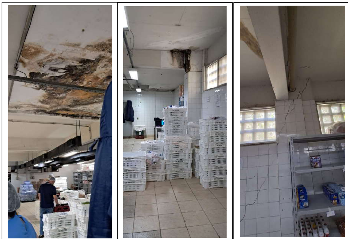
Fotos 73, 74 e 75. Visita ao prédio do Serviço de Nutrição e Dietética. Área do estoque, com infiltrações graves no teto e extensa rachadura na parede. Hospital Federal dos Servidores Públicos do Estado. Data: 14/11/2025, às 12h26, 12h26 e 12h27. Créditos: Secretaria da Comissão da Saúde.
