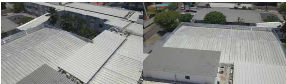
Obras na cobertura da unidade
