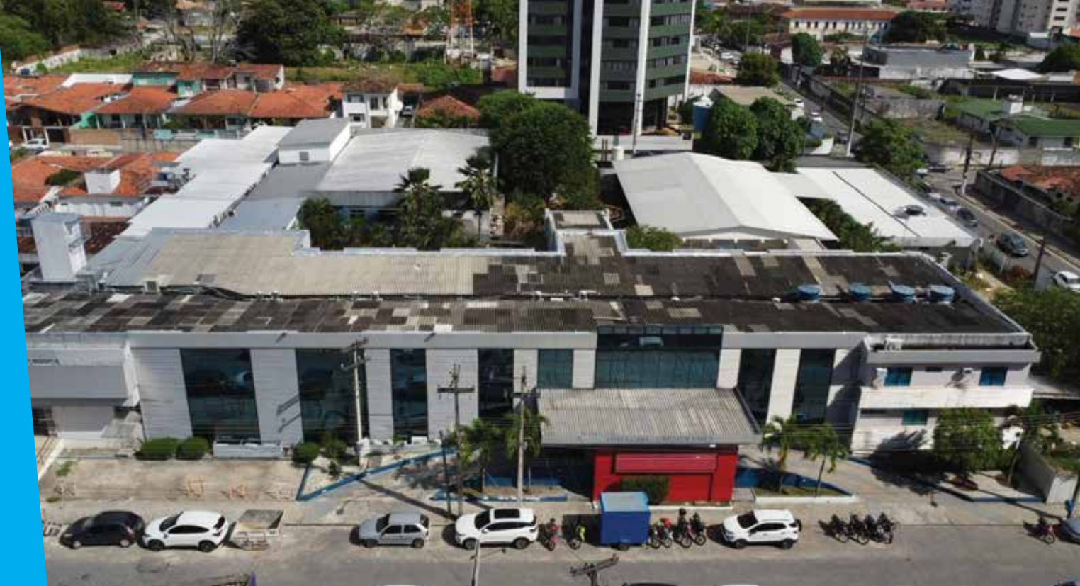
Telhado antes do trabalho da Gestão de Expansão
