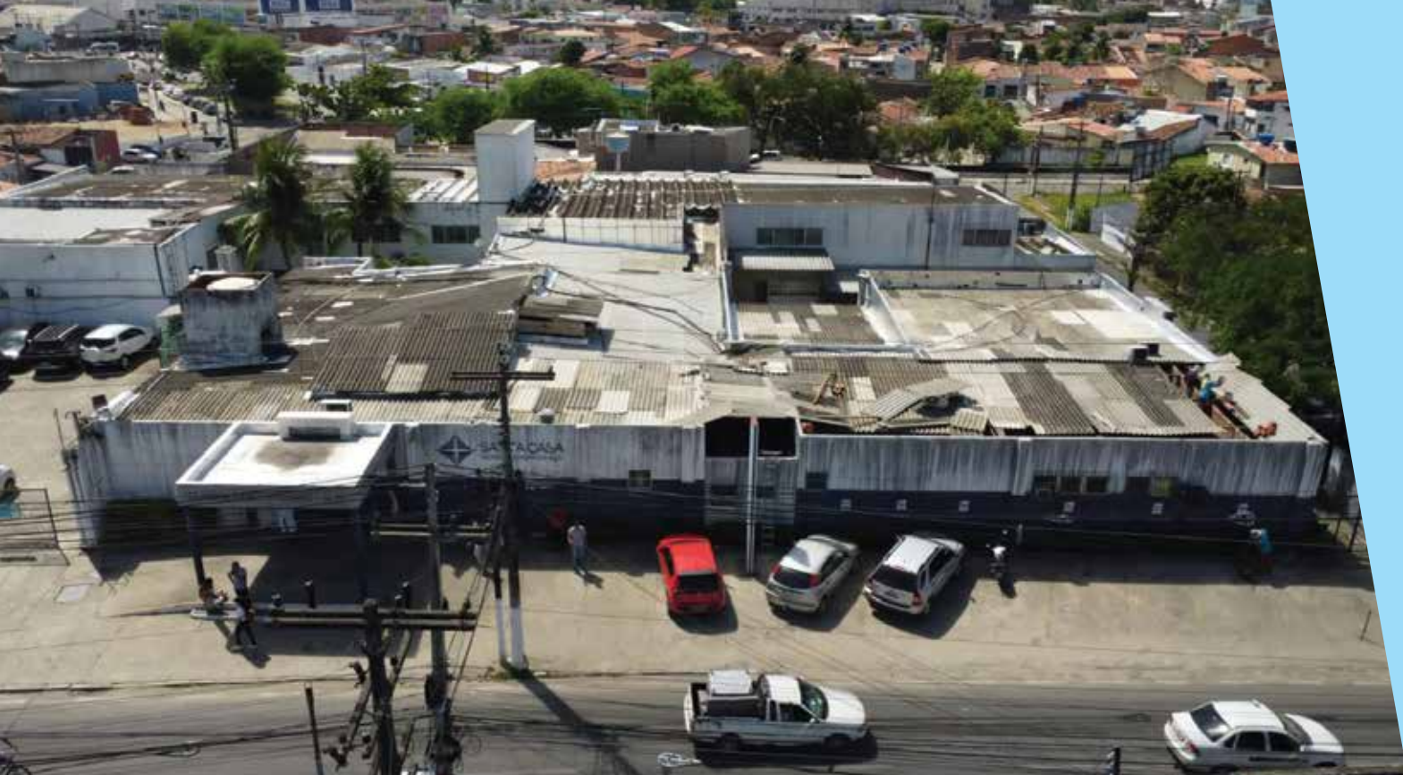
Telhado antes das melhorias estruturais
