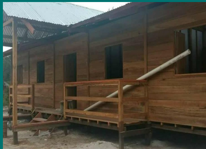
UBS em construção no DSEI Alto Rio Negro Amazonas
