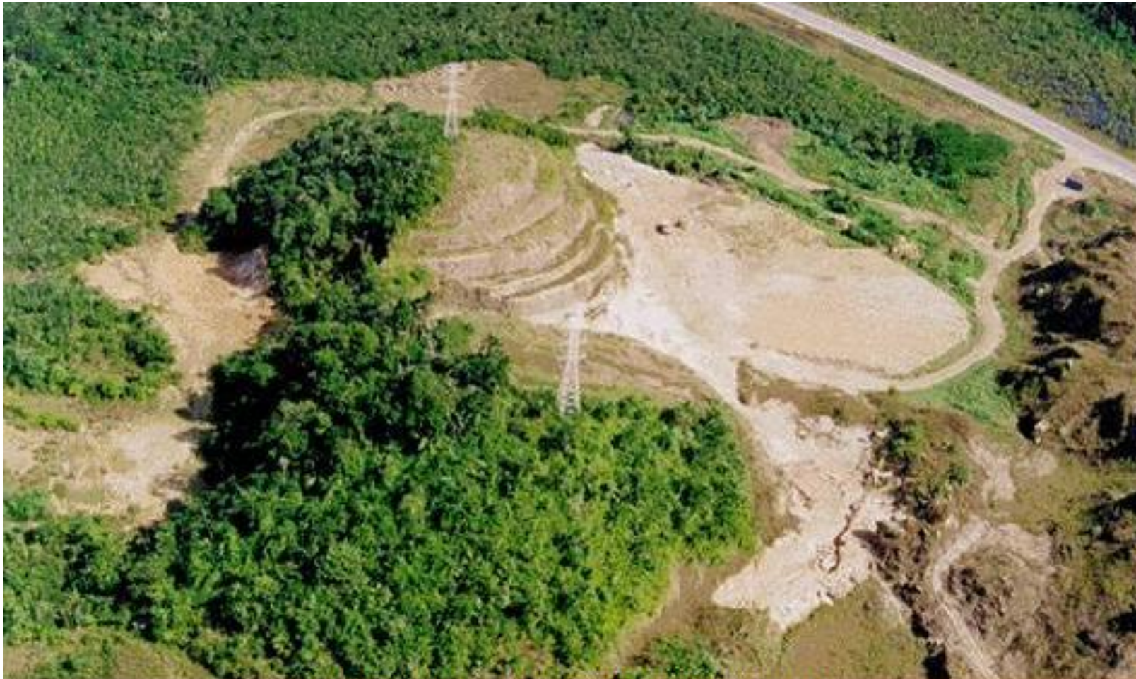
Figura C.1: Lixão de Bertioga junto à BR 101 Fonte: DPLA/ DPRN, 1999.
