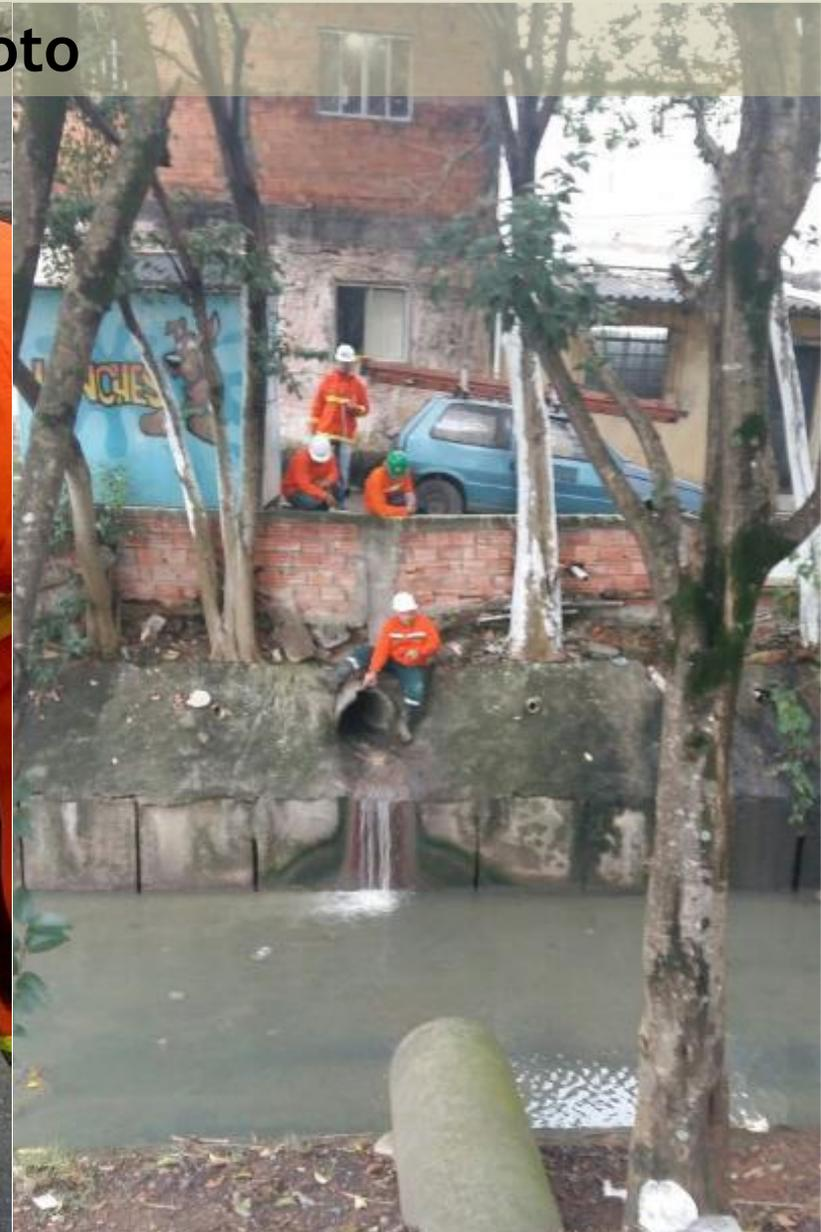
**Córrego à 70 m do ponto de Vazamento, saída do esgoto: 100% de explosividade.**
