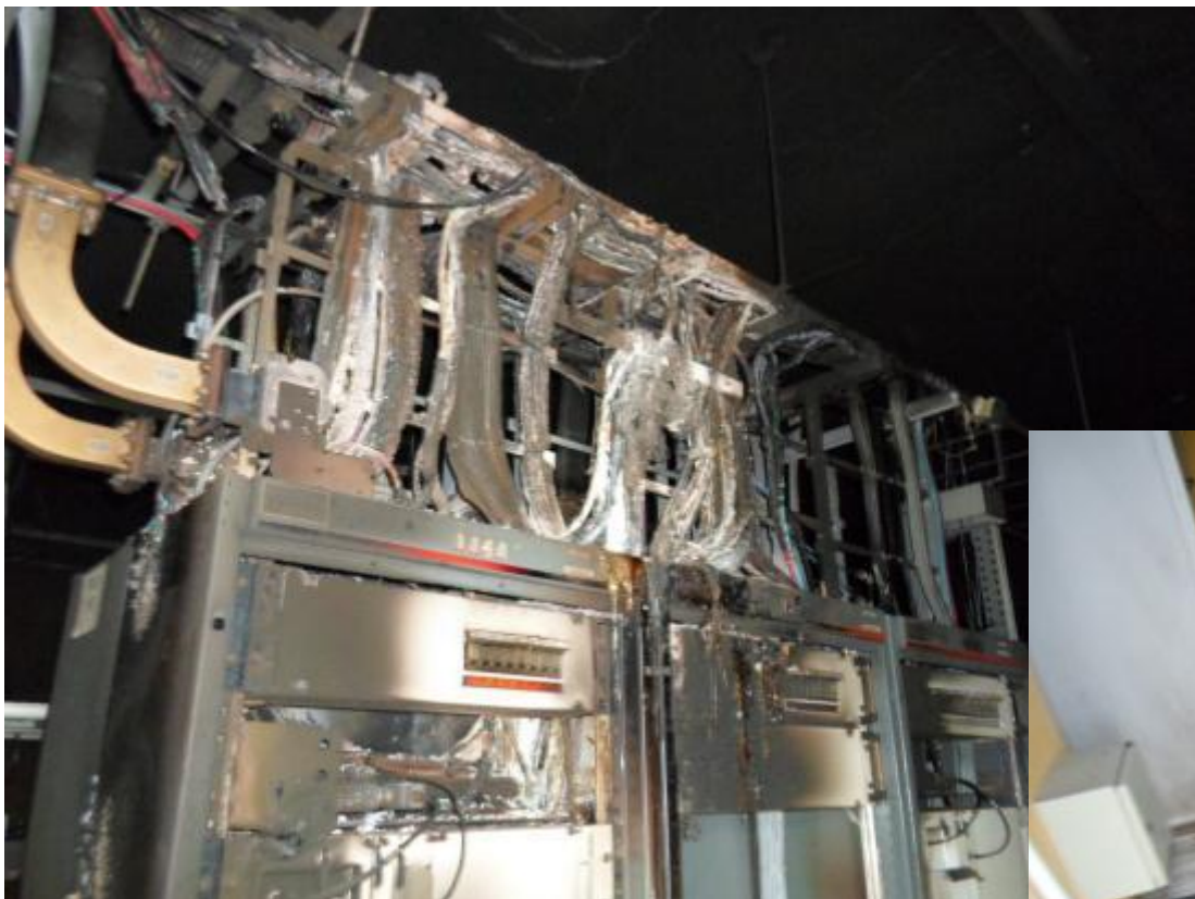
Fotos internas das antenas incendiadas
