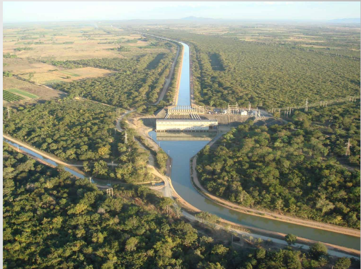
No projeto de irrigação do Jaíba, a água é captada no rio São Francisco e, por meio de um sistema de canal a céu aberto, é levada até às plantações
