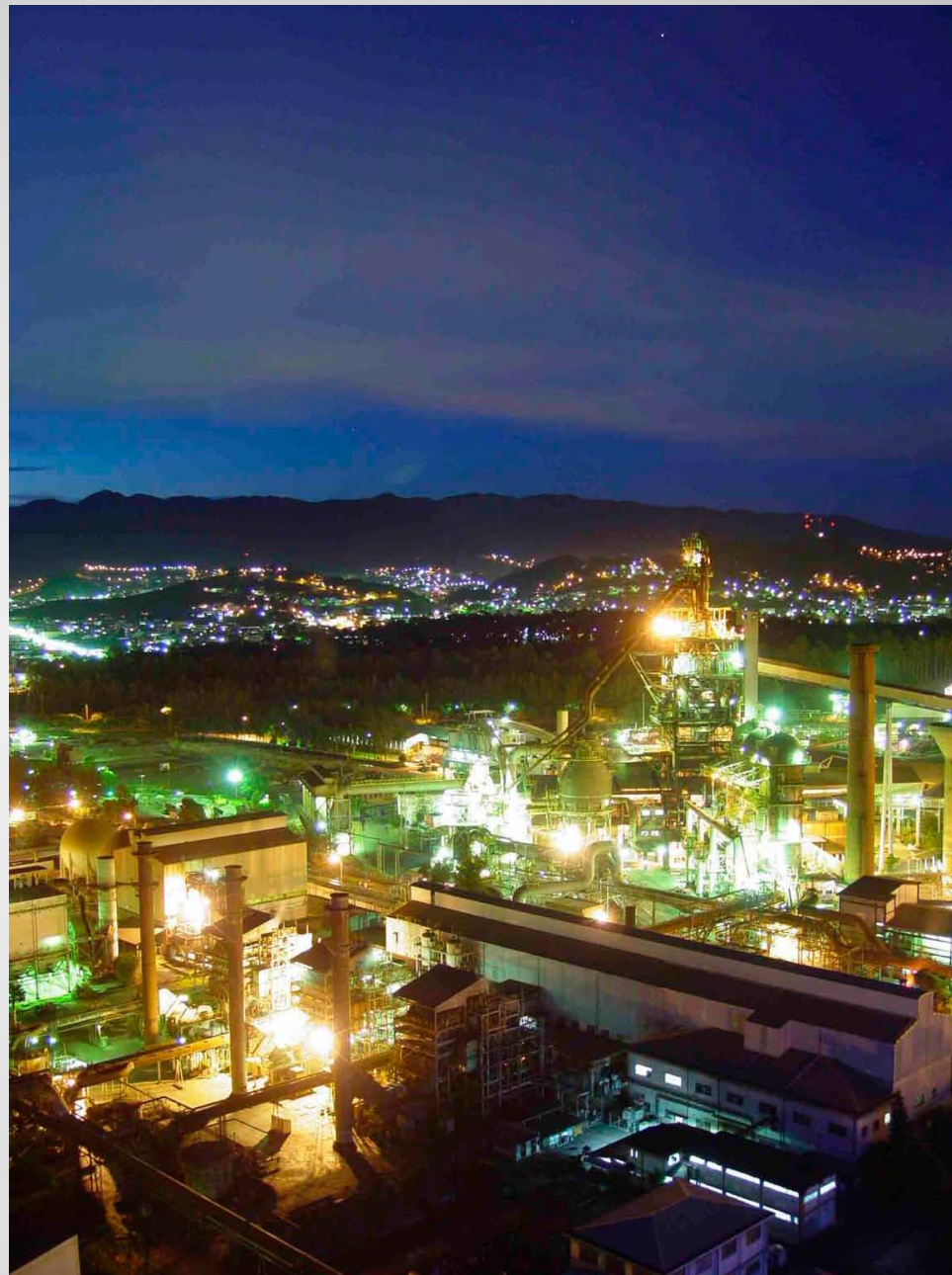
Usiminas - vista geral e de cima das instalações da sinterização e do alto-forno
