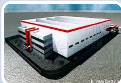
Construção de unidade fabril
