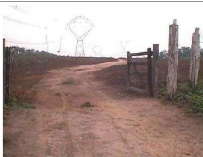
Foto 3.222. Sítio SP 1. Acesso às torres 108/2 e 109/3.
