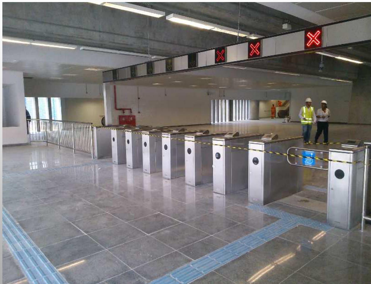
Estação metroviária de Bom Juá - Salvador
