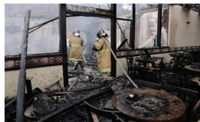
Explosão e incêndio deixam 4 feridos no Kiosque do Alemão, em Itaboraí Idoso ficou em estado grave; gestante inalou fumaça e teve crise nervosa 05/05/17
