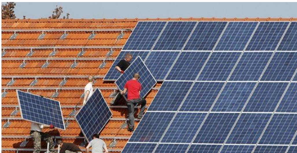
Falhas na Instalação / Execução do Projeto
