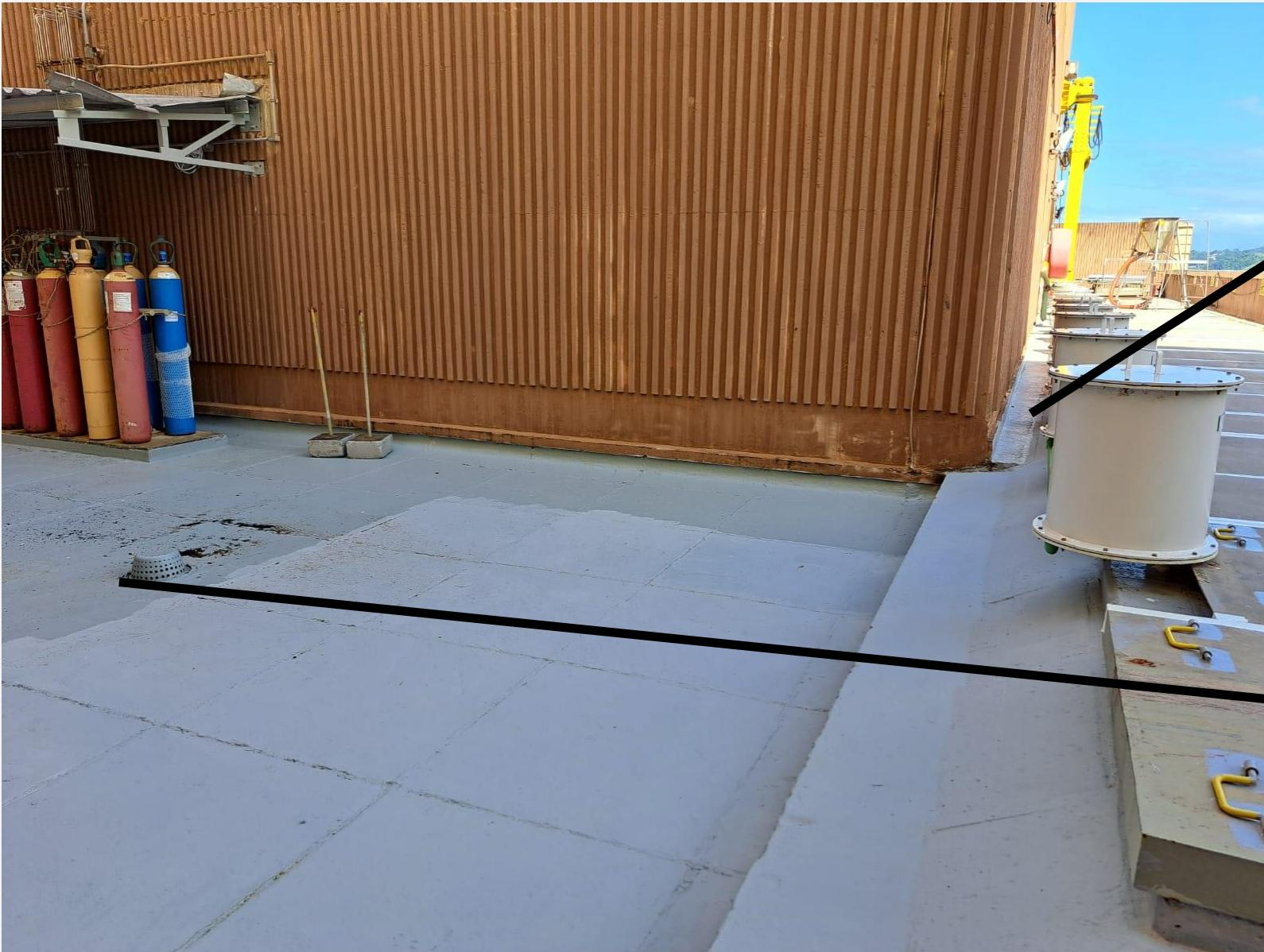
Canaleta onde ficou contido o vazamento do sistema de drenagem dos casulos.
