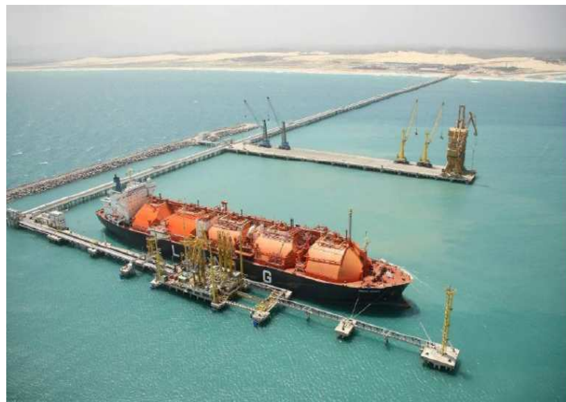
Terminal de Regaseificação de Gás em Pecém/CE Capacidade: 7 milhões m 3 /dia Fonte: Petrobras
