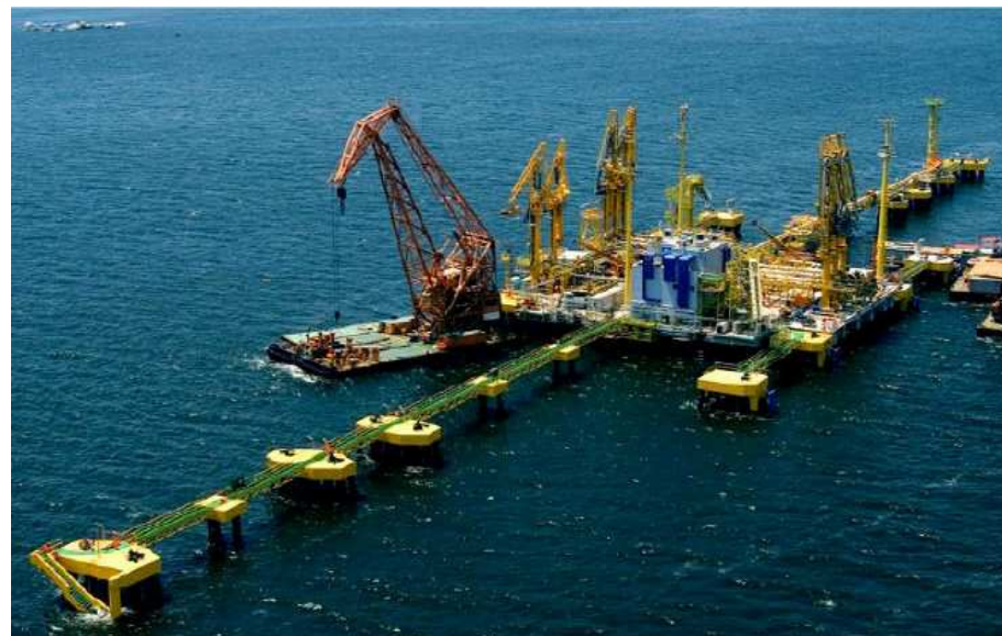
Terminal de Regaseificação de Gás na Baía de Guanabara/RJ Capacidade: 14 milhões m 3 /dia. Fonte: Petrobras
