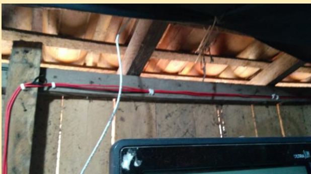
▶ Adequações de Instalações
