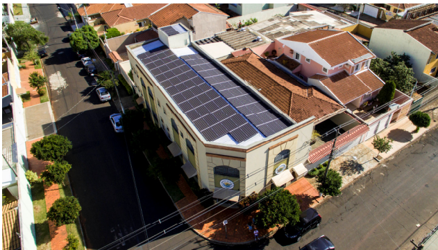
Edifício comercial do segmento farmacêutico, Ribeirão Preto (SP).
