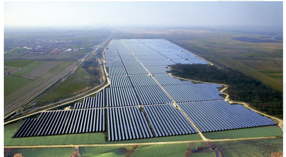
UFV de 225 MWp em Ituverava (BA).
