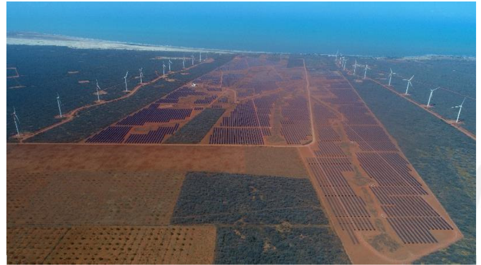
UFV de 101 MWp em Areia Branca (RN).
