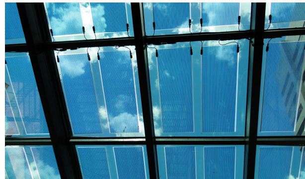
Claraboia solar fotovoltaica em edifício comercial bancário, São Paulo (SP).
