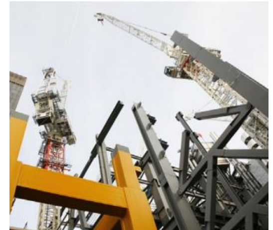
VIGAS PARA CONSTRUÇÃO
