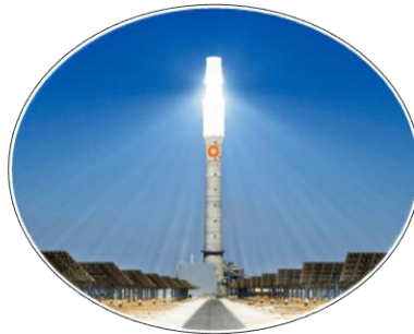
HELIOTÉRMICA TORRE CENTRAL
