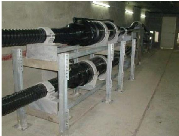
Emendas pré-fabricadas: Testes elétricos
