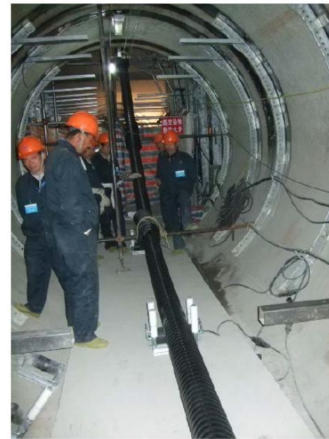
Lançamento dos cabos
