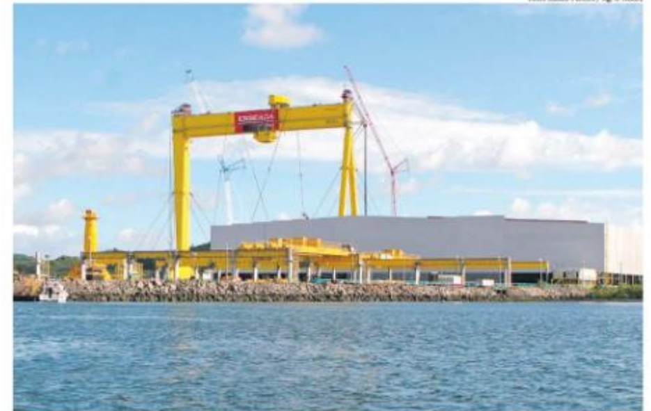
A montagem do superguindaste Goliath, de 150 metros de altura, já foi concluída pela Enseada Indústria Naval
