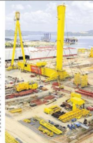
A montagem do superguindaste segue até março
