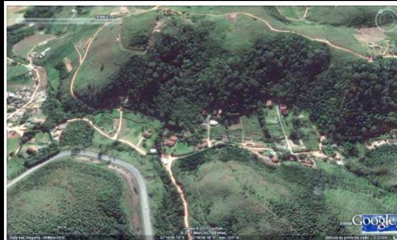
Figura 64: Vista de região com parcelamento do solo com construções na meia encosta de morro com inclinação superior a 45° e com topo do morro desmatado. Observa-se construções também na margem dos cursos d'água. BR 492 em Nova Friburgo. (Google Earth de 26.05.2010).
