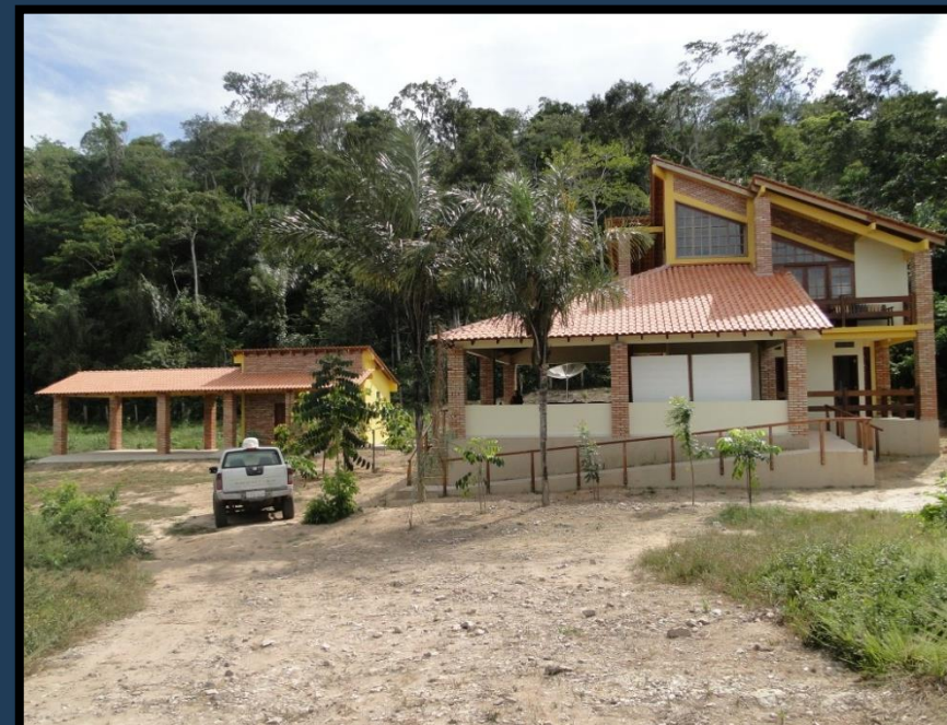
Sede de apoio construída no PARNA SERRA DA CUTIA, RO
