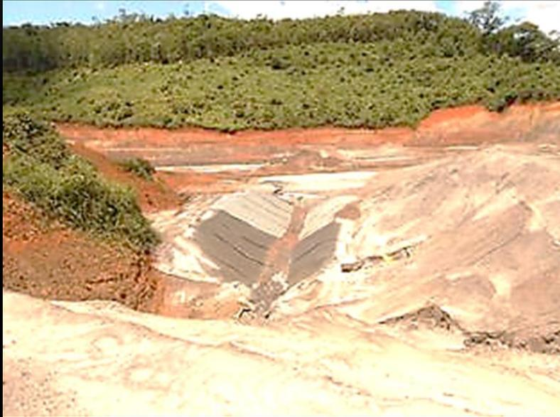
Canal trapezoidal aberto revestido com geotêxtil
