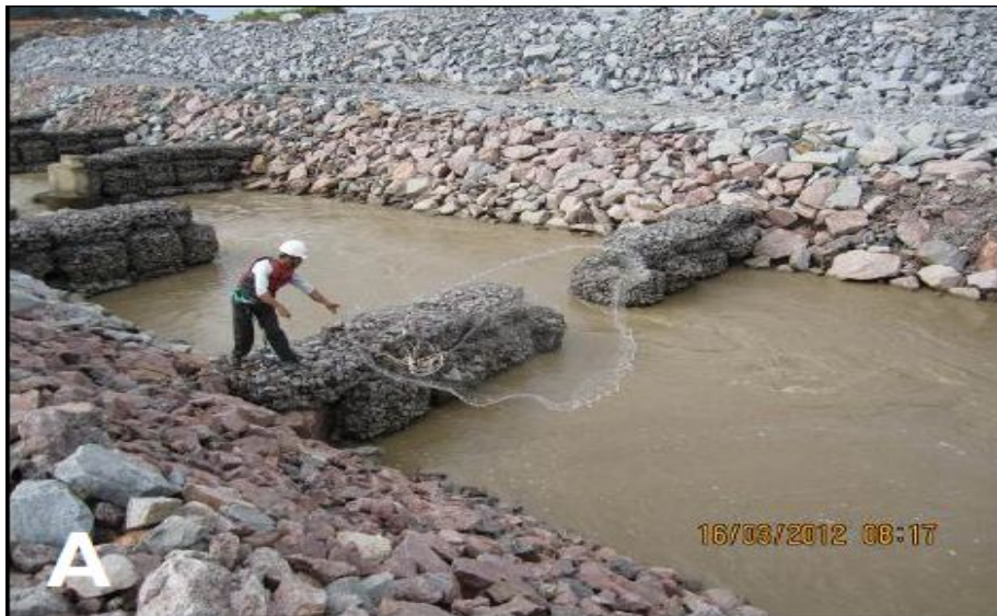
Escada de peixes da UHE Belo Monte.
