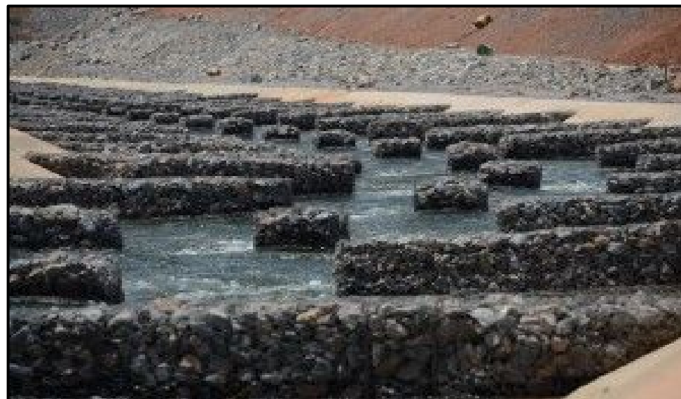
Escada de peixes da UHE Belo Monte.
