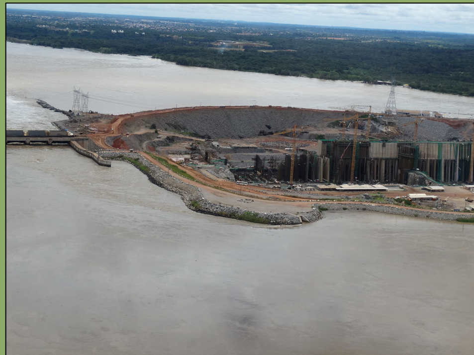
UHE Santo Antônio, estado de Rondônia.
