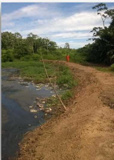
Contenção da Lagoa de Chorume
