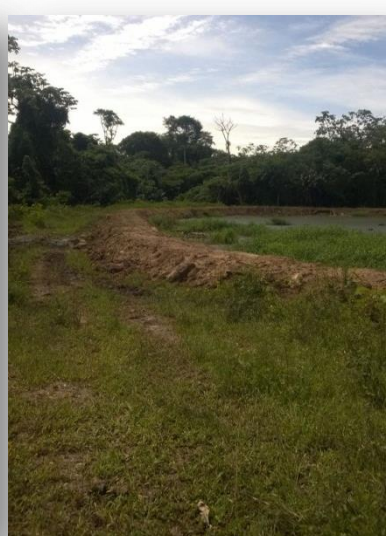
Contenção da Lagoa de Chorume
