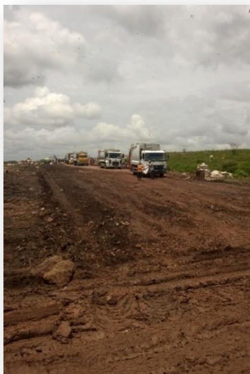
Rampa de acesso do lixo domiciliar
