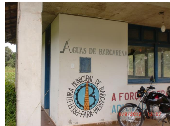
Estação de bombeamento de água VCabanos
