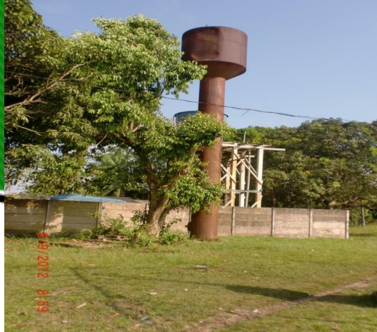
Estação de bombeamento de Vila Nova
