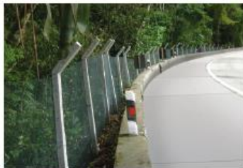
Telas foram instaladas em alguns trechos para evitarem travessias de animais.
