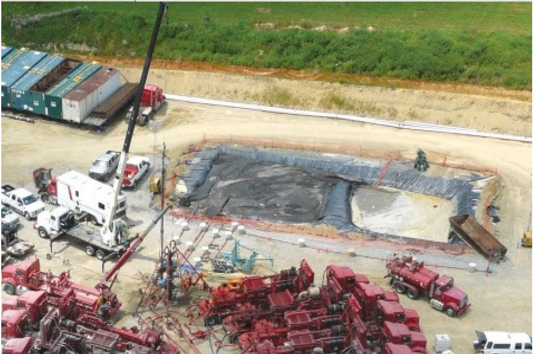
Instalações para extração do Gás de Xisto (cf, apres_hugo_affonso_anp_aajdaha6aa. pdf)
