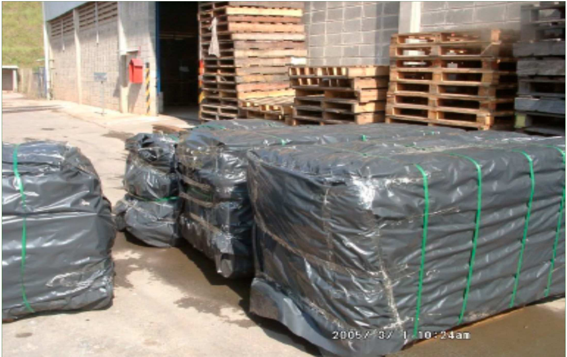
Resíduos com amianto embalados em filme plástico resistente sobre pallets e cintados.
