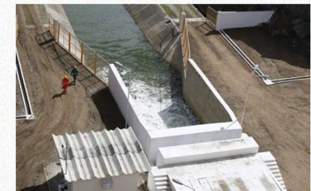
Vertente Litorânea da Paraíba ( R$ 1,4 bi – 80% de execução física)
