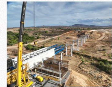
Ramal do Apodi ( R$ 1,6 bi – 51,74% de execução física)
