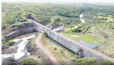
Arroio Taquarembó (R$ 228,5 mi – 60% de execução física)
