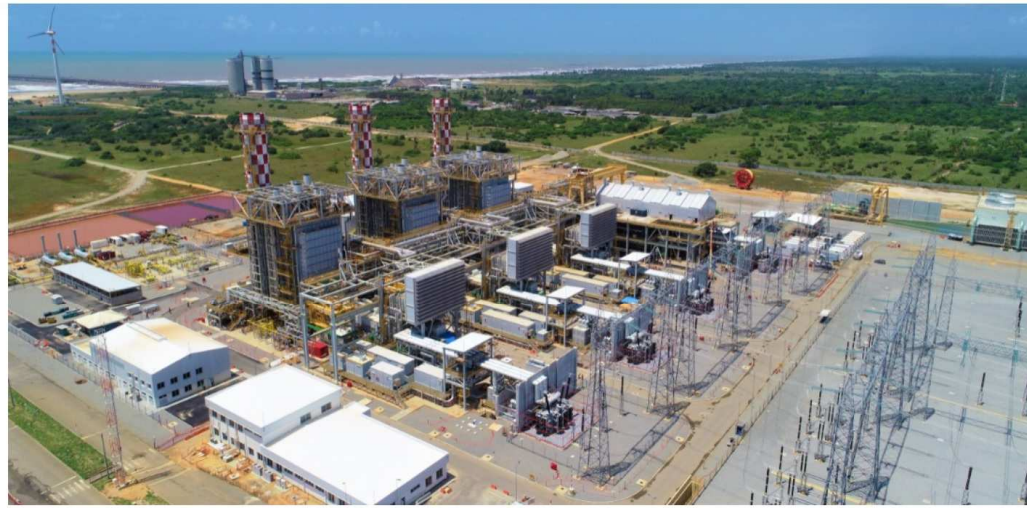
A Usina Termoeletrica Porto de Sergipe I, de capacidade de geracao de 1.551 MW, conta com tres turbinas a gas 7HA e uma turbina a vapor, de fabricacao da General Electric (GE), alem dos demais sistemas usuais em uma usina de ciclo combinado: caldeiras de recuperacao de vapor, condensadores, torre de resfriamento, sistemas e tratamento de agua e efluentes e subestacao. Este e o primeiro projeto no Brasil a receber o modelo de turbina 7HA, considerado hoje o mais eficiente disponivel no mercado.
