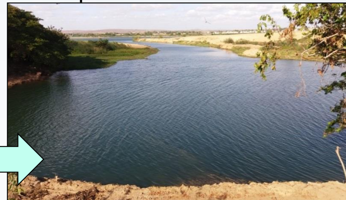
Depois da Obra
