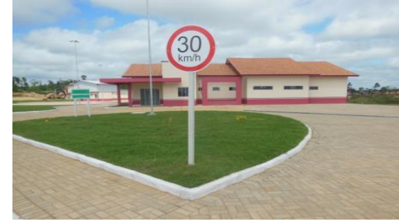
Aterro Sanitário - Outubro/2013
