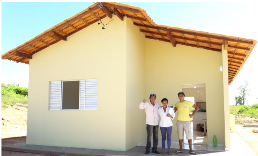
Reassentamento Individual em Área Remanescente - RAR
