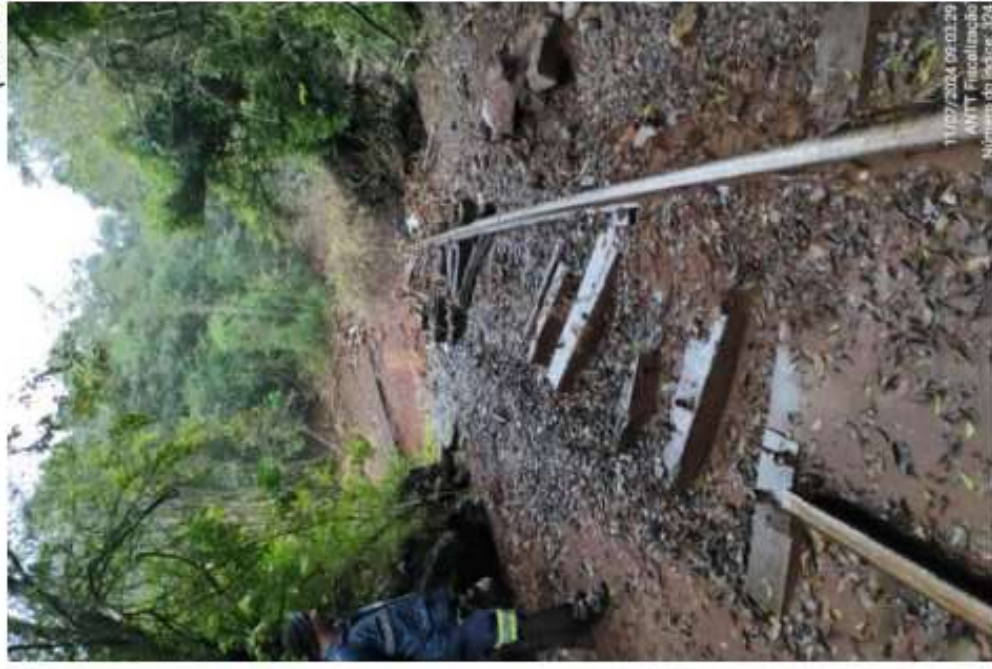
Fotos 51 a 54 – Linha arrancada, via permanente e entrada de túnel soterrados por grande escorregamento de encosta (km 149+000).
