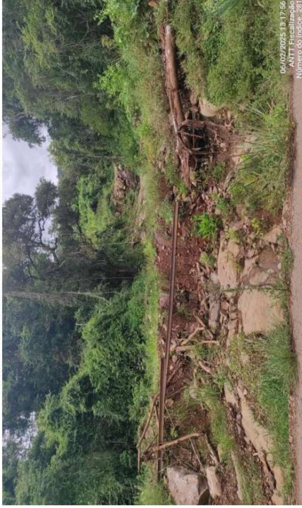
Foto 156 – Linha arrancada por escorregamento (km 131+796).
