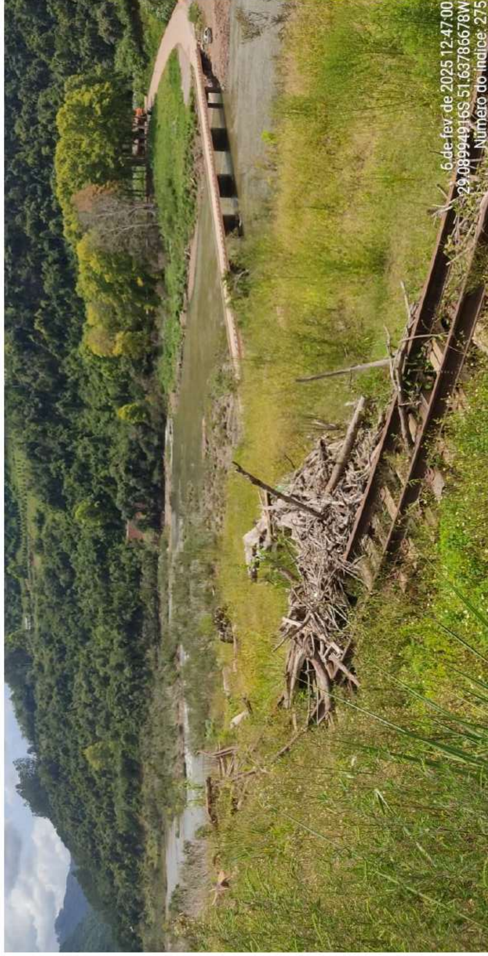
Fotos 143 a 150 – Ponte ferroviária obstruída por troncos e linha, bueiro e galeria destruídas (km 138+755).
