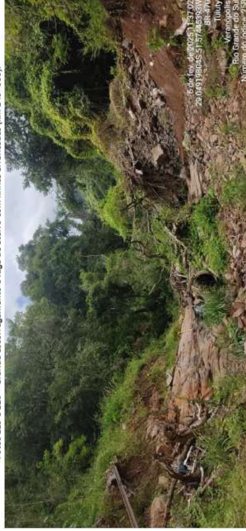
Fotos 119 e 120 – Grande escorregamento e fuga de aterro com linhas arrancadas (km 149+000).
