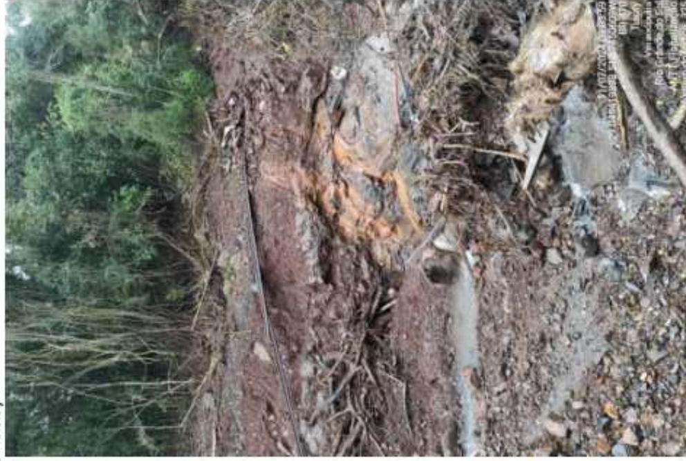
Fotos 51 a 54 – Linha arrancada, via permanente e entrada de túnel soterrados por grande escorregamento de encosta (km 149+000).
