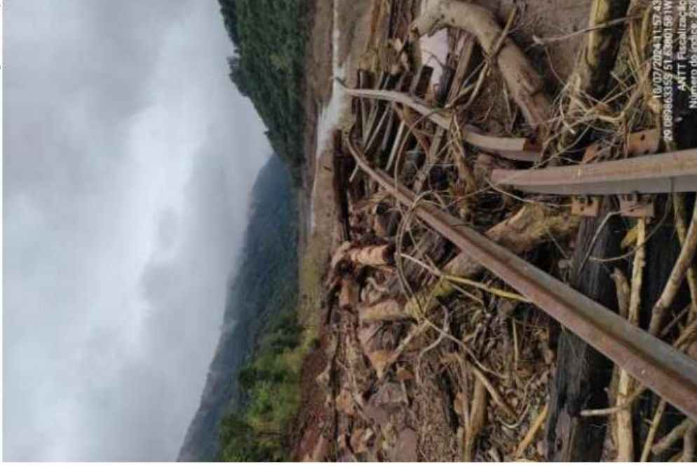
Fotos 21 a 23 – Grade arrancada por grande deslizamento de terra no segmento Santa Tereza - Jaboticaba, em Bento Gonçalves (km 138+755).
