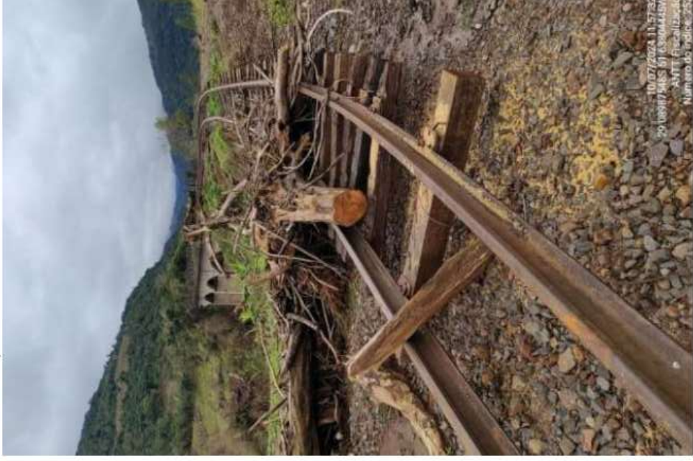
Fotos 21 a 23 – Grade arrancada por grande deslizamento de terra no segmento Santa Tereza - Jaboticaba, em Bento Gonçalves (km 138+755).
