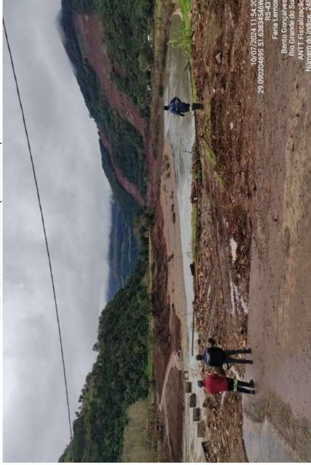
Fotos 26 a 28 – Linha férrea arrancada e ponte rodoviária destruída pelo transbordamento do Rio das Antas, no segmento Santa Tereza - Jaboticaba (km 138+755).
