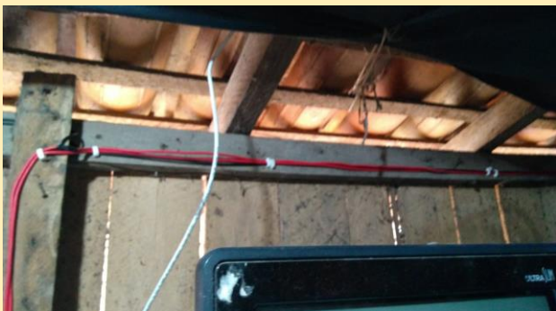
▶ Adequações de Instalações
