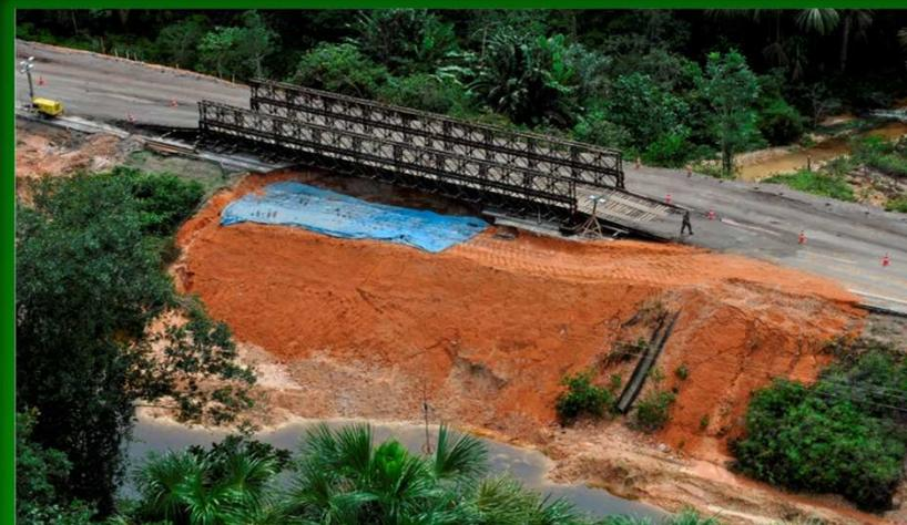
**lançamento de Pnt Bailey de 27,42m e capacidade de 55 Ton, no Km 57 da BR 174 – estabelecendo tráfego interrompido por desmoronamento de bueiro**
