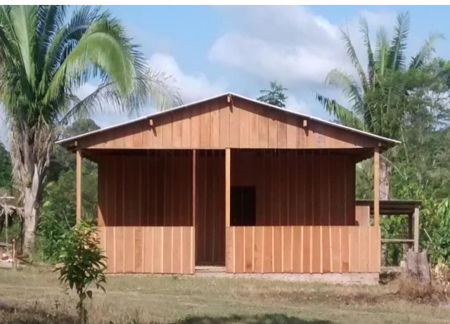
Casa de Moradia em Madeira - Aldeia Paquiçamba
