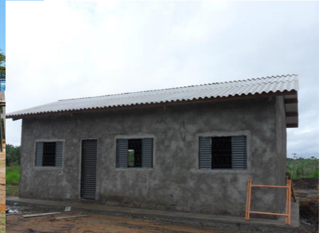
Casa de Moradia em Alvenaria - TI Trincheira do Bacajá.
