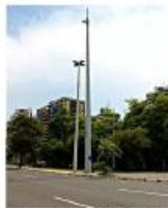
Antena está instalada na Av. General Faria na Fonte Negra (Foto: Jucelyne/AM)
