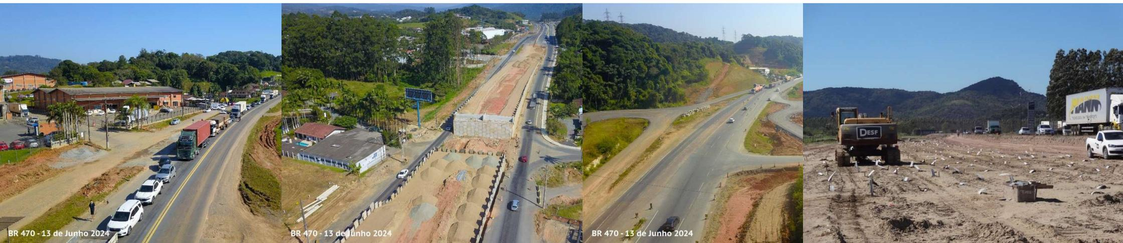
**“Destaque nos adensamentos das bases do pavimento que estão ocorrendo nas novas pistas de rolamento nos lotes 1 e 2, - em alguns segmentos pontuais executados sobre subleitos em solos moles.”**
