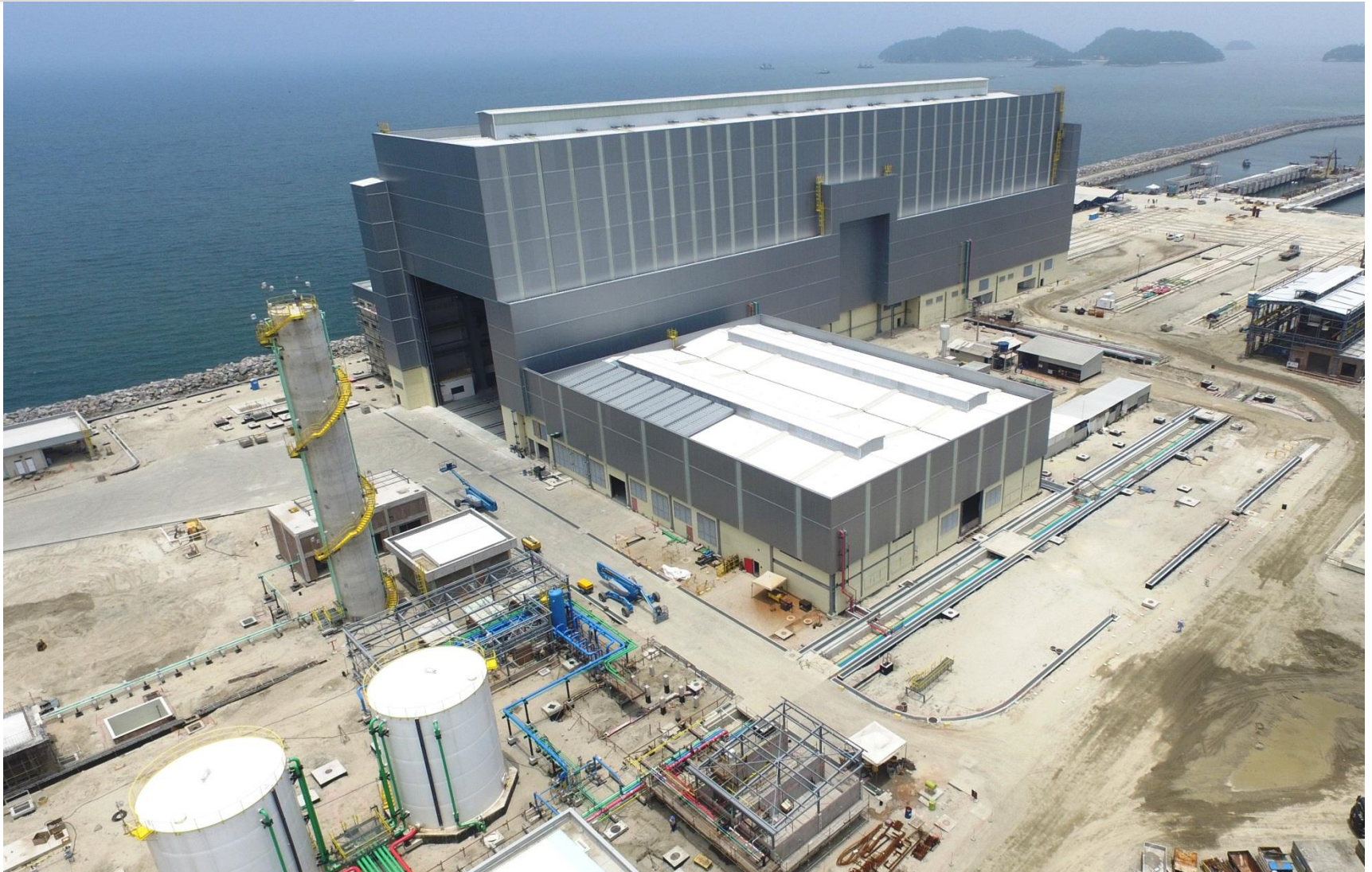
Vista aérea Central de Utilidades e Prédio de Apoio – Novembro/2015
