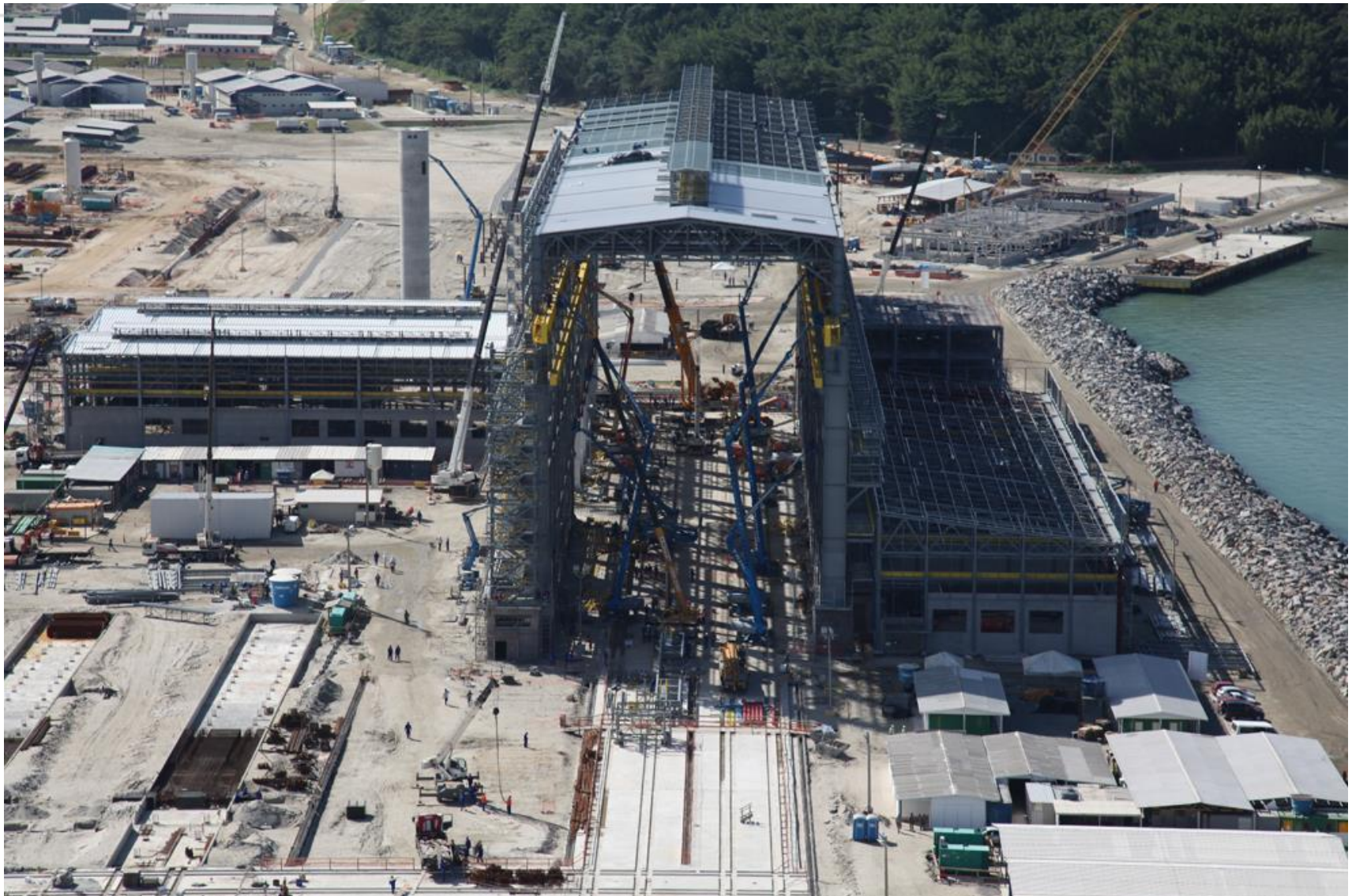
Vista aérea do Estaleiro de Construção – Novembro/2014
