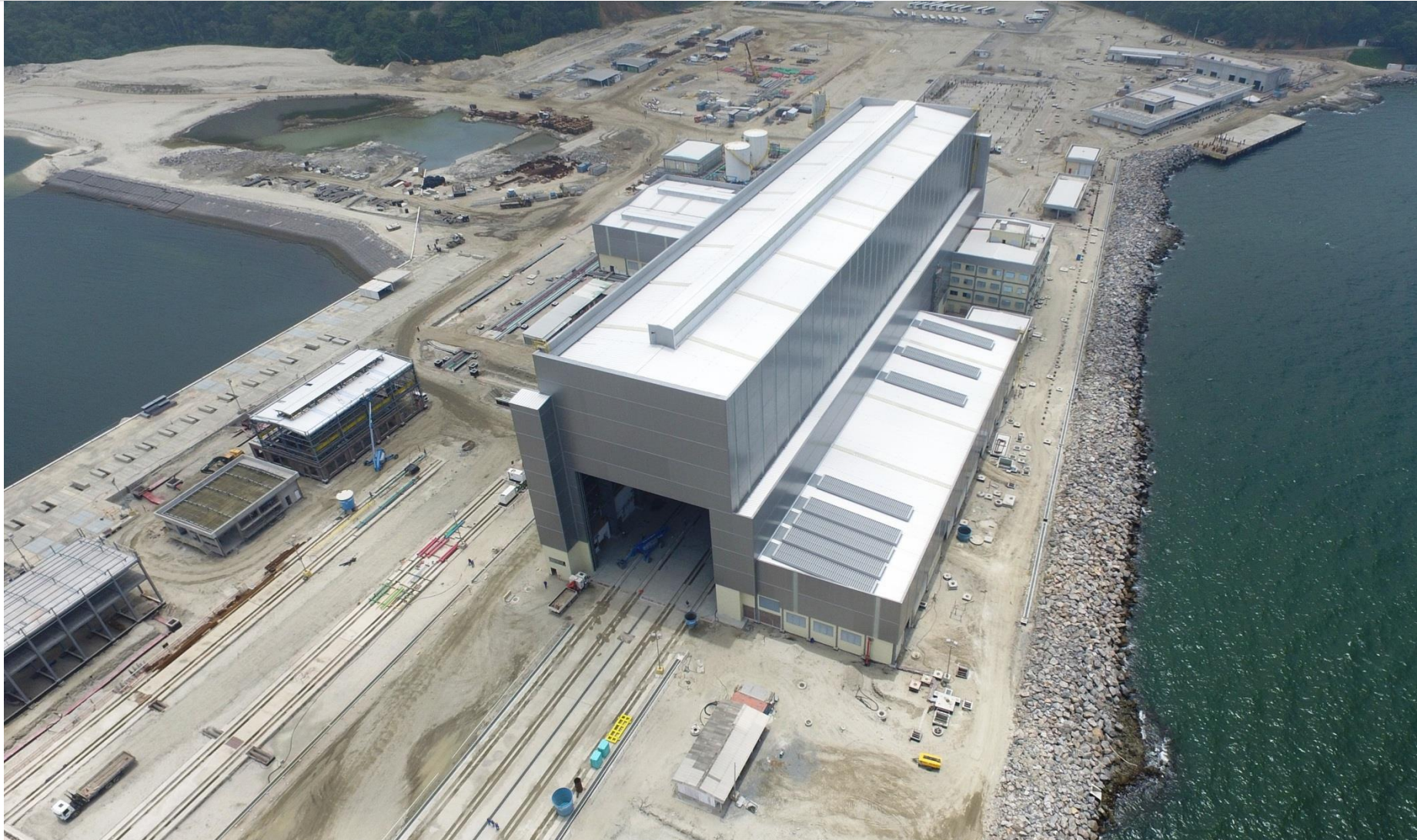
Vista aérea do Estaleiro de Construção – Novembro/2015
