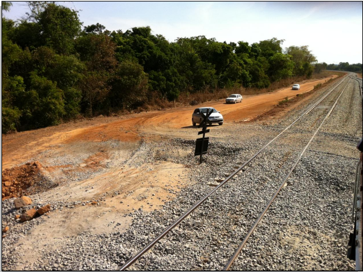
Ferrovia Norte-Sul, trecho próximo a Gurupi, Estado de Tocantins
