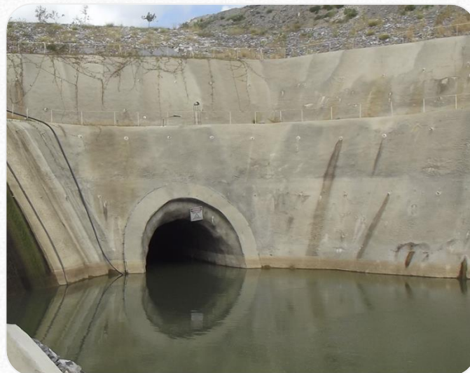
Túnel Engenheiro Giancarlo (PB)
