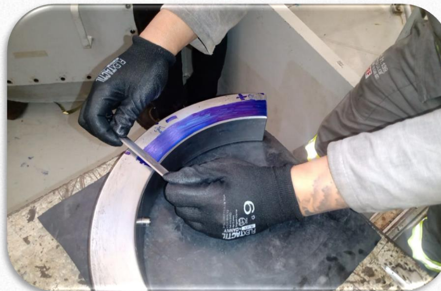
Preparação de anel para montagem
