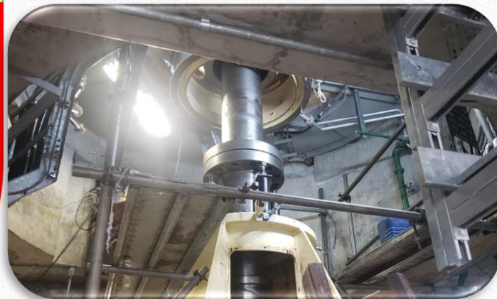
Desmontagem do eixo do conjunto motobomba
