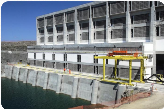
Estrutura de Controle – EBI-1 (PE)
