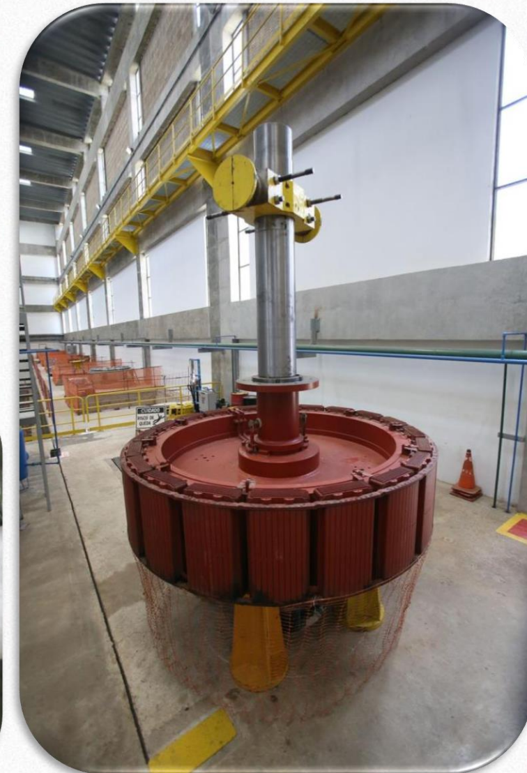
Eixo e isoladores desmontados
