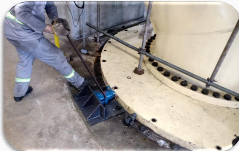
Serviço de alinhamento vertical do conjunto motobomba
