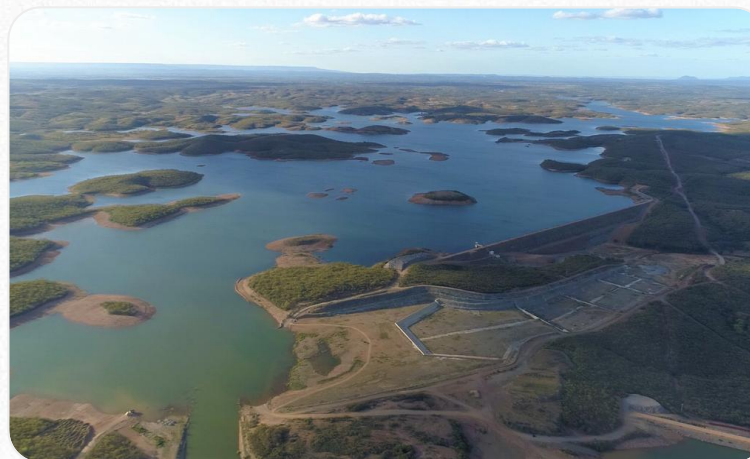
Reservatório Milagres (PE)
