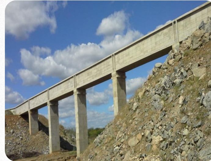
Aqueduto Branco (PE)
