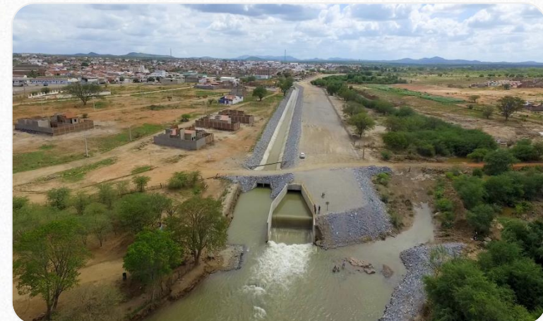
Estrutura de Controle (Monteiro-PB)
