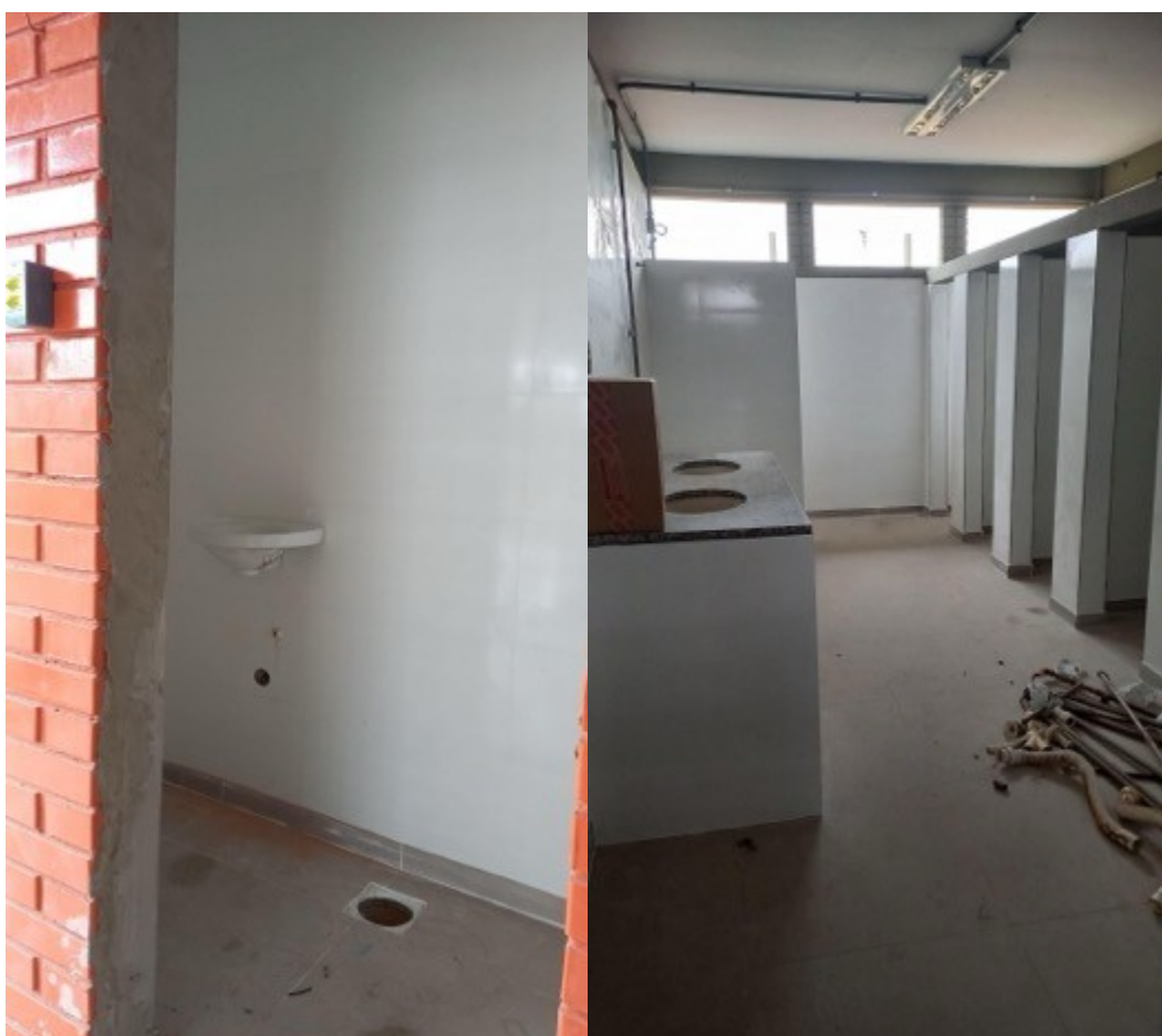
Figura 18, 19 e 20: Instalações sanitárias inacabadas.
