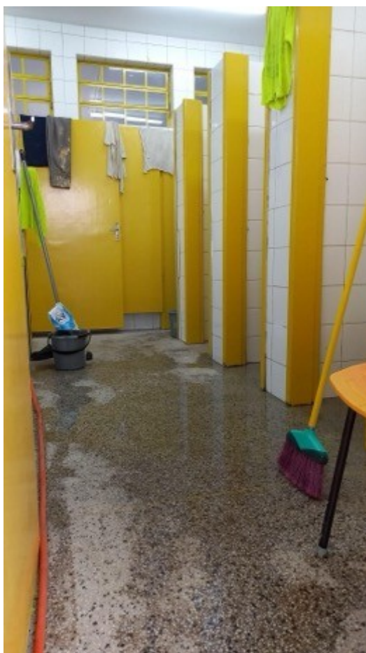
Figura 27 e 28: Instalações sanitárias com problemas de vazamento.
