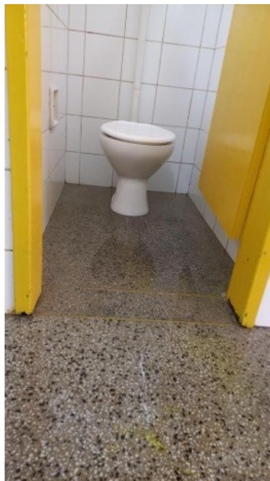
Figura 27 e 28: Instalações sanitárias com problemas de vazamento.
