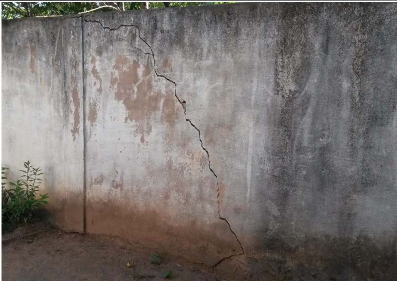
Destaque - Muro - EEEFM Aristeu Aguiar - Alegre/ES
