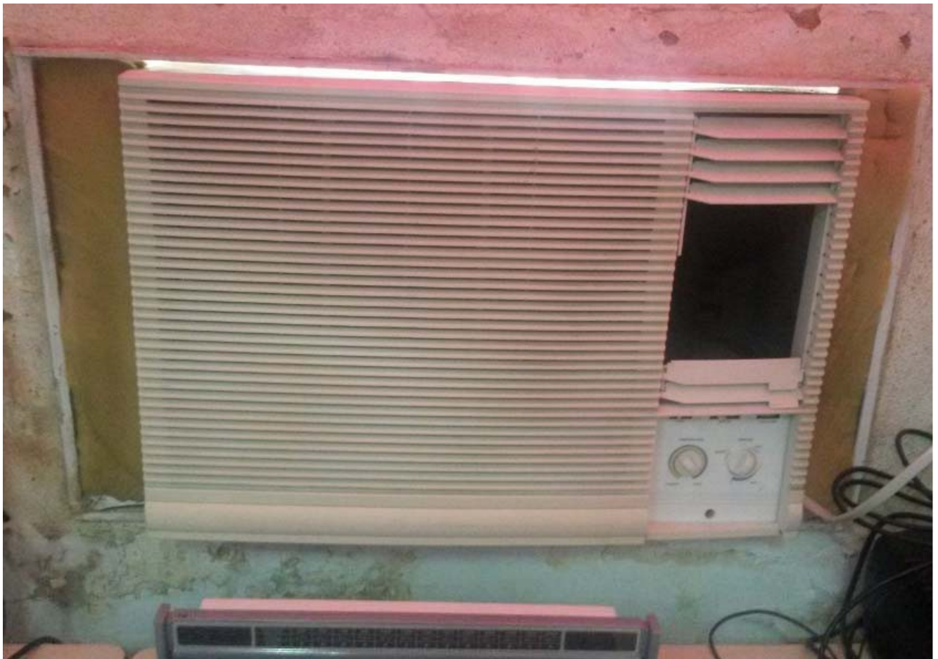
Infiltração em Laboratório de Informática - EEEFM Jerônimo Monteiro - Jerônimo Monteiro/ES
