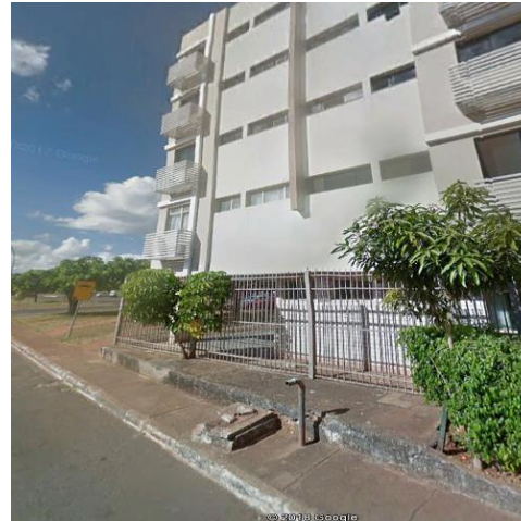
Calçada com largura menor que 1.20m
