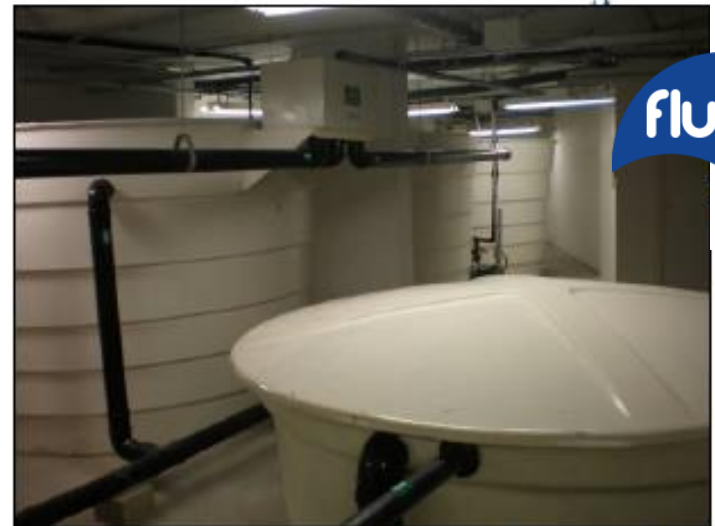
Figura 2 – Vista Geral da ETAC
