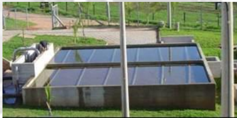
Pré-filtração ascendente em pedregulho
