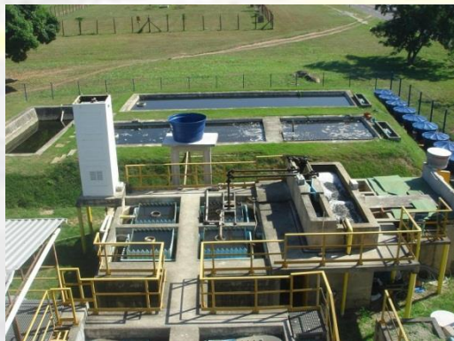
Estação experimental de tratamento de esgoto - UFRJ
