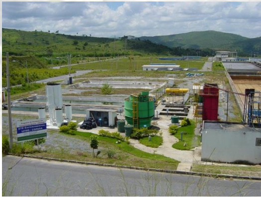
Estação experimental de tratamento de esgoto - UFMG/COPASA
