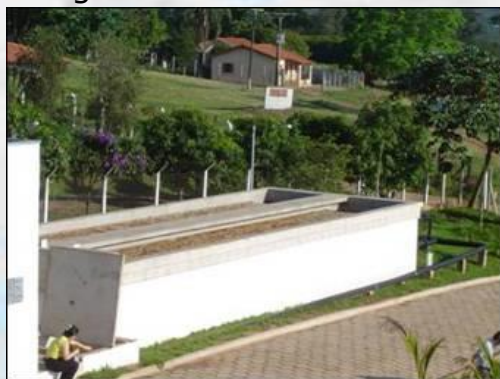
Pré-filtração dinâmica em pedregulho
