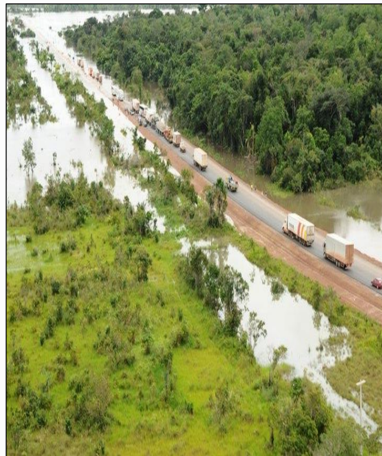
Parte da BR 174 que liga Boa Vista a Manaus submersa pelo avanço do nível das águas. Comprometimento do escoamento da produção
